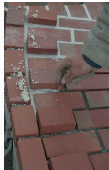
Vorgefertigter Sturz, der verfugt wird
