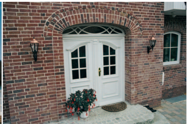
Türsturz über der Eingangstür
