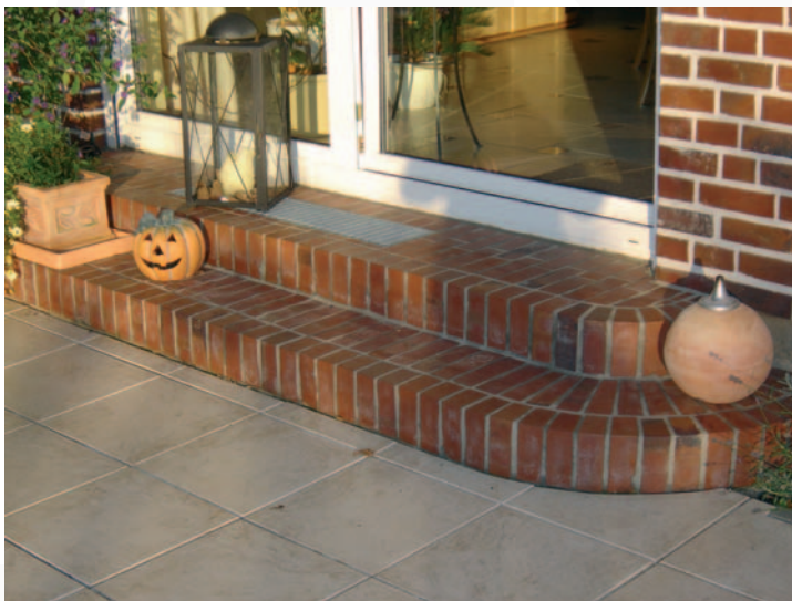
Terrassen-Eingang, der mit vorgefertigtem Stufen-Element versehen ist
