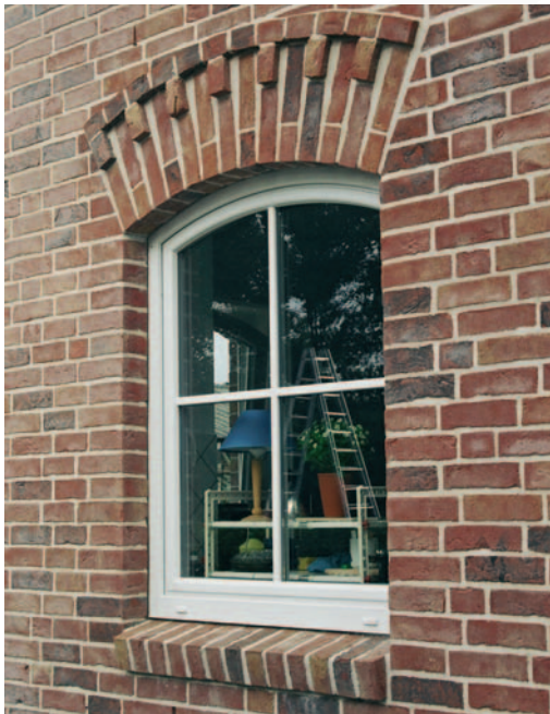
Detailansicht eines Fenstersturzes
